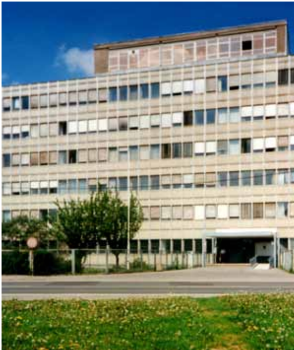
Dienstgebäude Leipziger Straße
